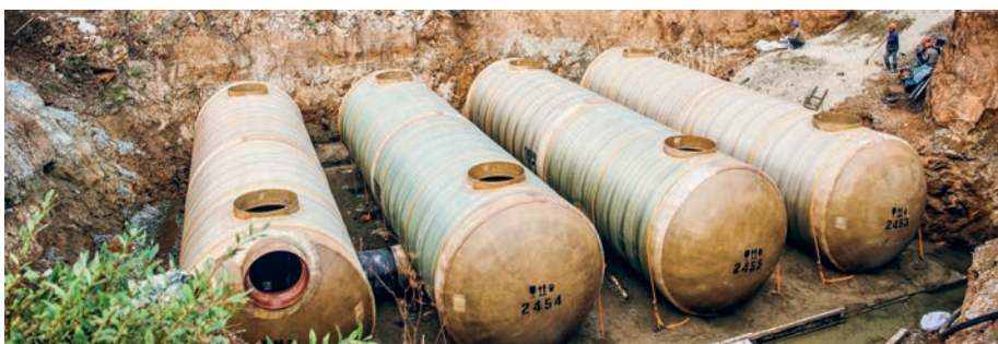
Резервуары общим объёмом 420 м 3 сумеют собрать всю влагу с территории нового корпуса
