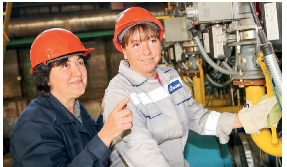
Операторы котельной Аида Пряничникова и Евгения Наумова сверяют параметры нового котла
