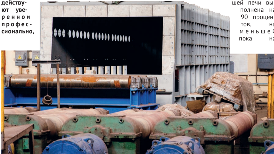
Одна из печей готовится к монтажу футеровки
