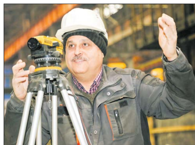
Прораб Юрий Запорожан с помощью нивелира выставляет контрольные точки фундамента
