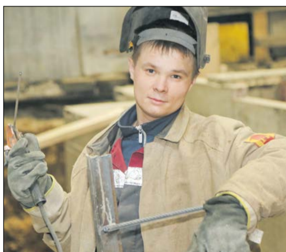
Сварщик Максим Степанов готовит арматурную сетку
